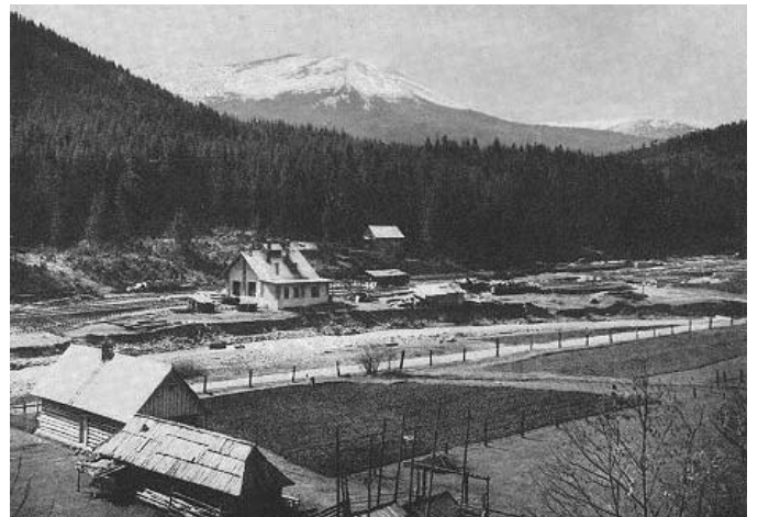
Egykori erdei vasút a hucul havasokban Forr.: www.iabsi.com
